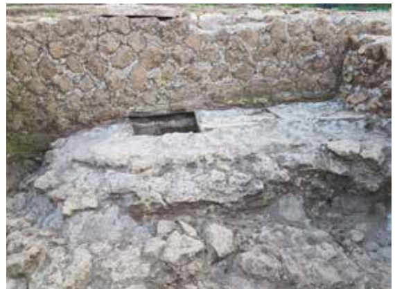
Afb. 18. De afdekking van het rioleringkanaal
