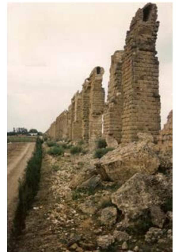
Afb.8. Brugpijlers van het aquaduct van Carthago in de Meliana vlakte, met kanaalresten er bovenop
