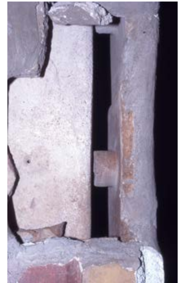
Afb. 1. ‘Spouw’ in het caldarium van de Casa del Menandro in Pompeii (foto: Nathalie de Haan)
