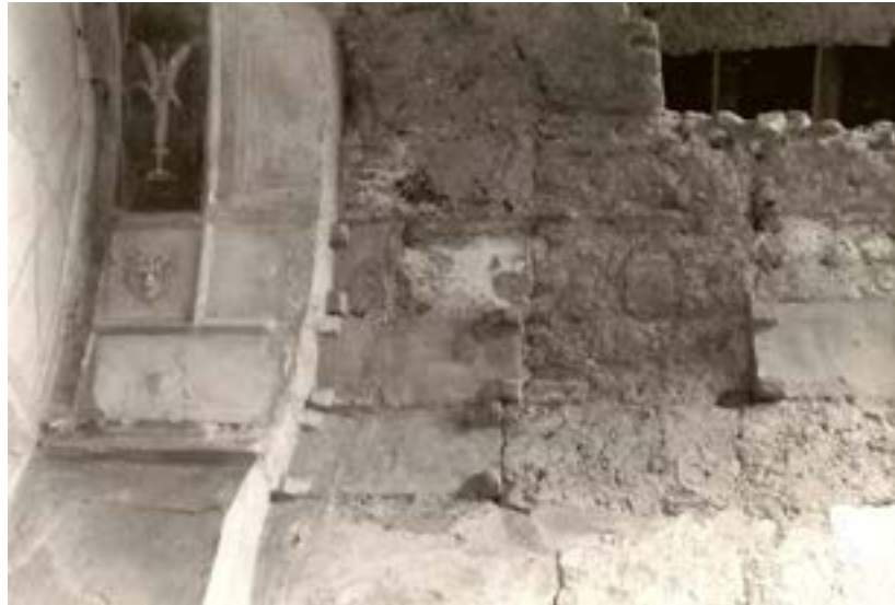
Afb. 2. Verwarmd gewelf in het caldarium van de Casa del Labirinto in Pompeii (foto: Nathalie de Haan)
