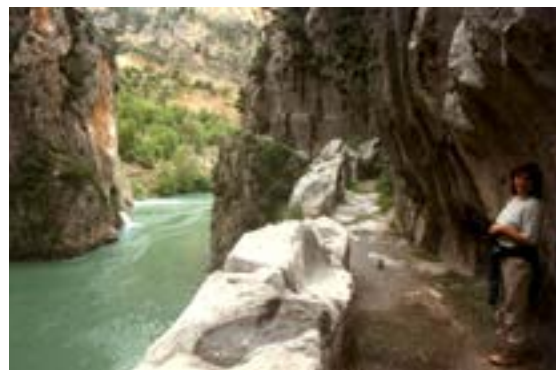
Afb.5. Kanaal van het aquaduct van Side, in rotswand van Manavgat rivier, zuidkust Turkije
