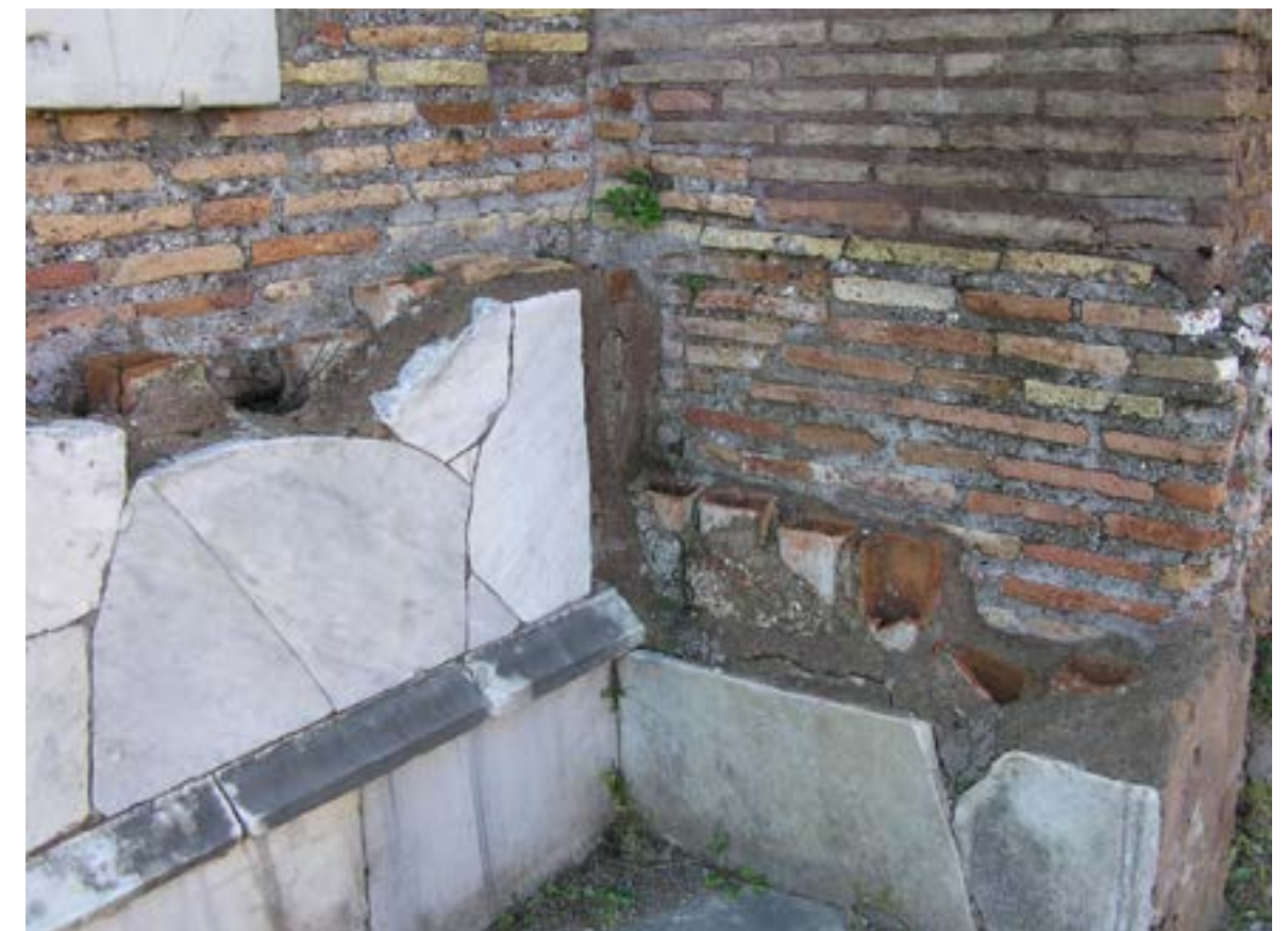
Afb. 5. Forumthermen in Ostia, caldarium : onderste rijen van tubuli , bezet met marmer (foto: Nathalie de Haan)
