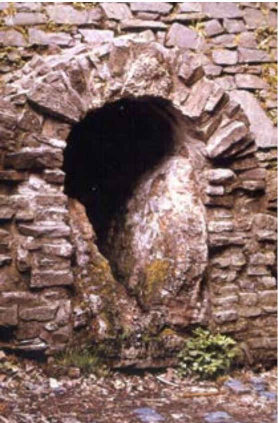
Afb.10 (links). Kanaal van het aquaduct van Keulen, met 30 cm kalkafzettingen aan beide wanden
